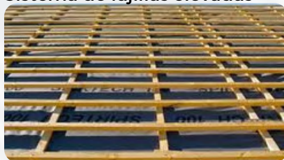
Sistema de fajillas elevadas
